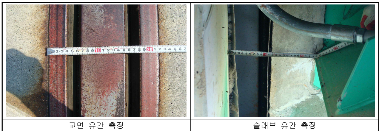
【사진 3.9】 유간 측정 현황
